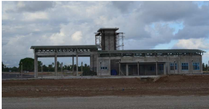
Progresu konstrusaun terminal aeroportu Suai
