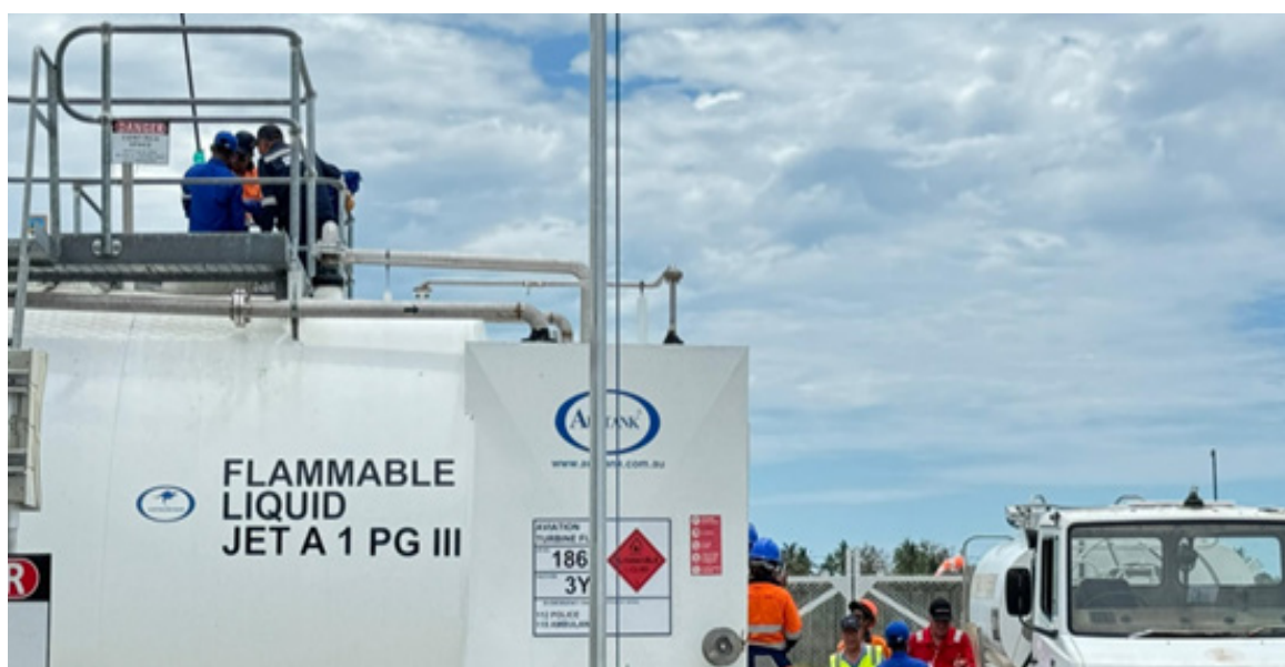
Figura 3.7: Manutenção de dois (2) depósitos de JET A1 nas instalações do Suai Aviation Fuel Facility (SAFF)
