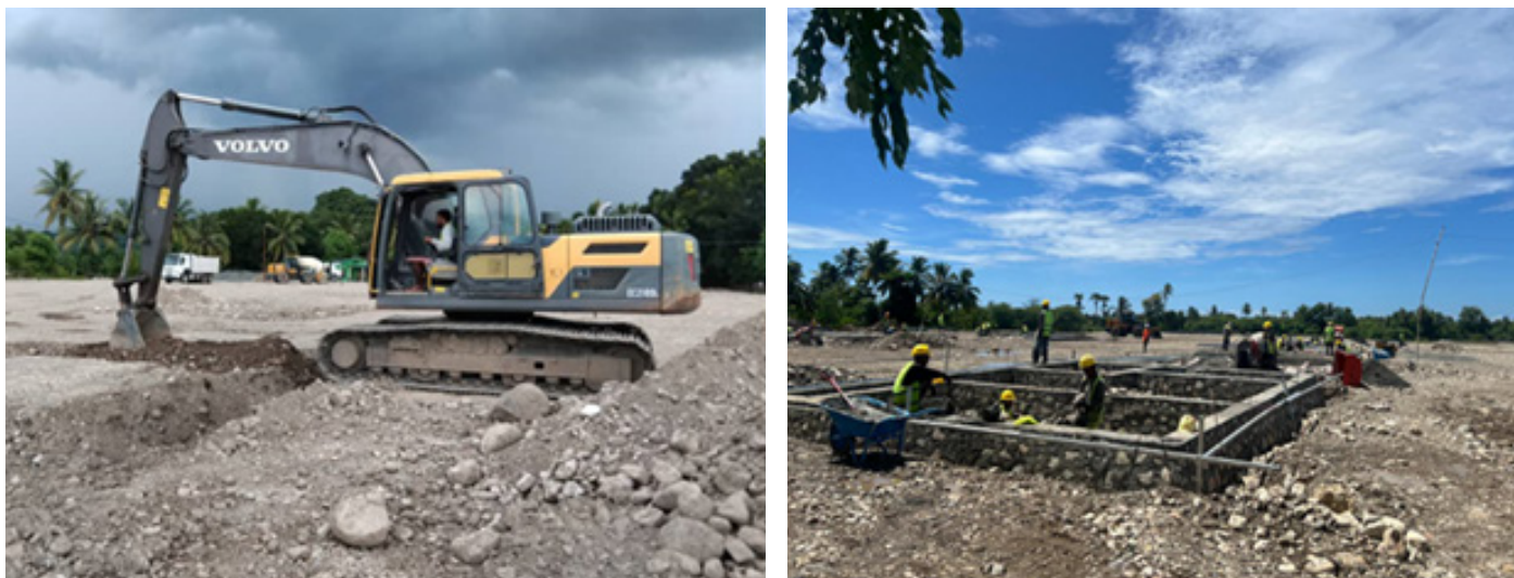
Figura 4.10: Atividades das construções em curso
