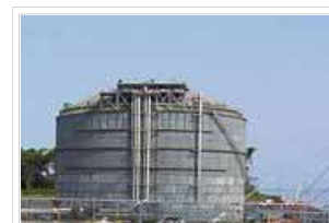
LNG storage tank at EG LNG
