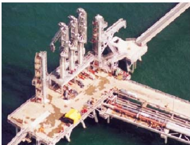
Figure 22. LNG Jetty with Unloading Arms - ALNG
