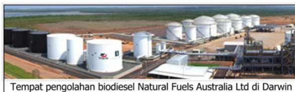
Tempat pengolahan biodiesel Natural Fuels Australia Ltd di Darwin
